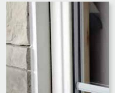
Finition avec moulure d'aluminium
